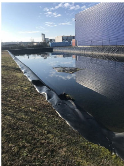
Bassin de rétention présentant une remontée de la bâche
