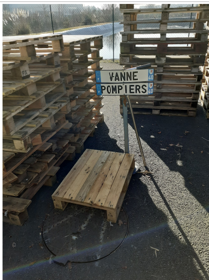
Vanne d'isolement du bassin de rétention cachée par des palettes
